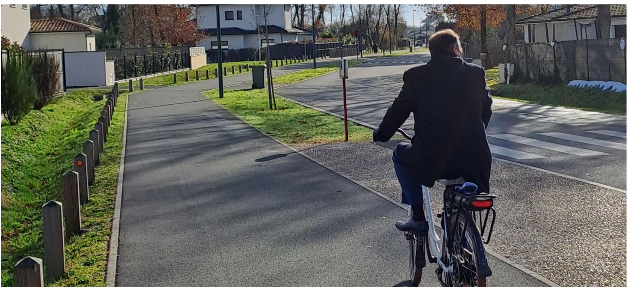
Aménagement cyclable en site propre dans un quartier résidentiel à Saint-Aubin-de-Médoc
