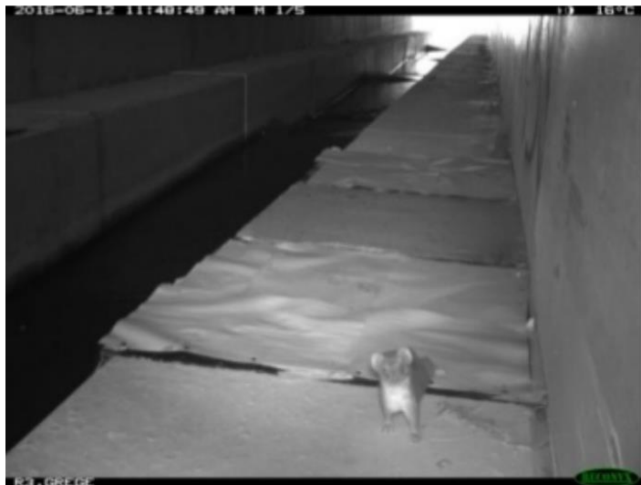
Photo 1 : Utilisation d'une banquette dans un ouvrage hydraulique par une belette (Source : Suivi Transparence mammifères semi-aquatiques - 2016 – GREGE)
