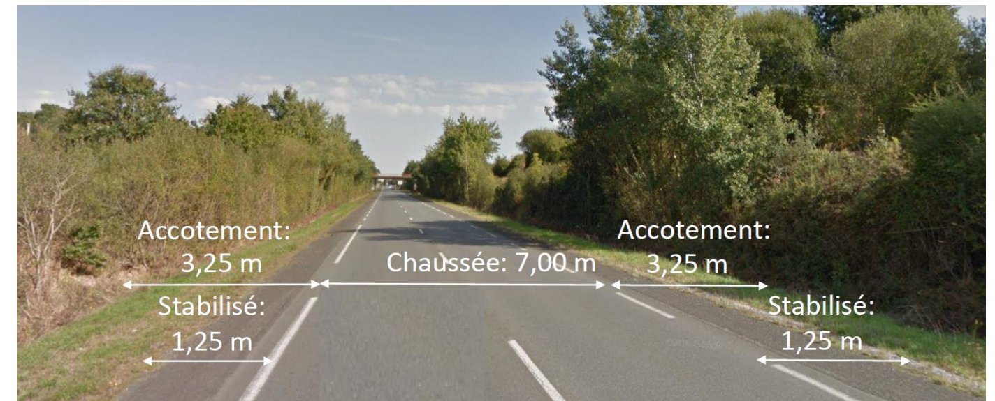
Figure 1 : Schéma du profil en travers du projet
